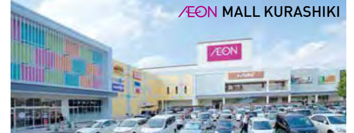
RSC-11 イオンモール倉敷 所在地: 岡山県倉敷市
