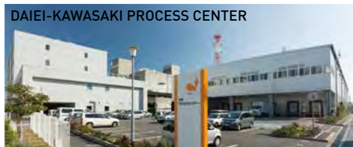
L-1 ダイエー川崎プロセスセンター 所在地: 神奈川県川崎市
