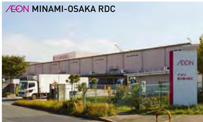
L-2 イオン南大阪RDC 所在地: 大阪府堺市
