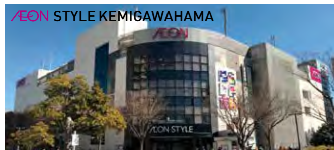
CSC-2 イオンスタイル検見川浜 所在地: 千葉県千葉市
